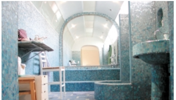
Ramzi Nammour a équipé ce pavillon du système domotique Tébés TS.
