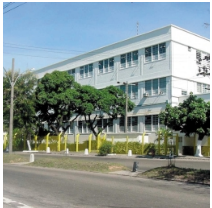
Eletromar Ltda, la nouvelle unité de production de Hager au Brésil, est située dans l'agglomération de Rio de Janeiro.
